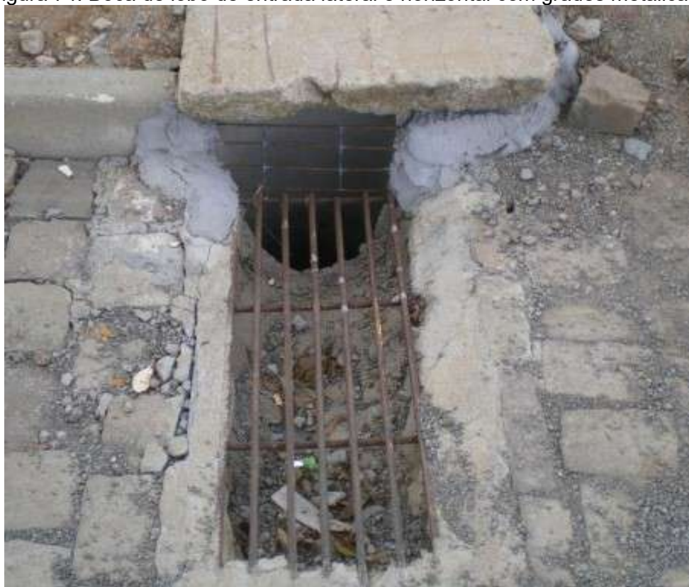
Figura 74: Boca de lobo de entrada lateral e horizontal com grades metálicas
