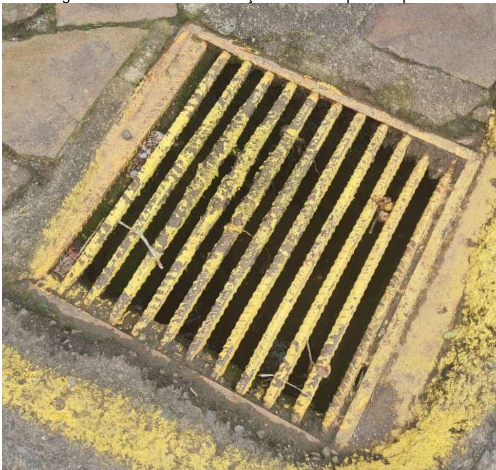
Figura 77: Boca de lobo avançando sobre o passeio público.
