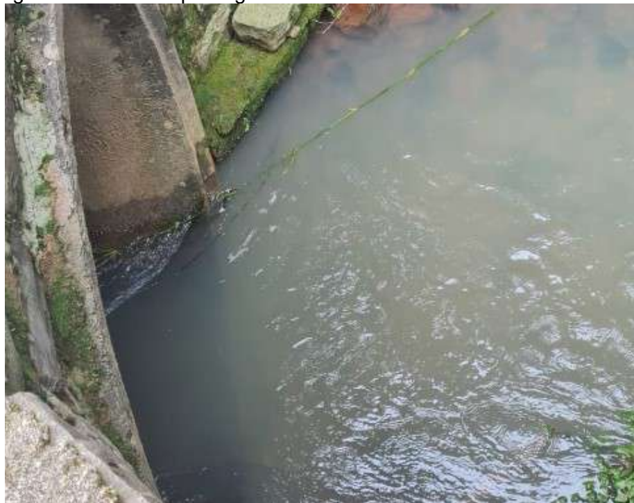
Figura 90: Dutos de passagem do Arroio Gabriel no cruzamento de vias.
