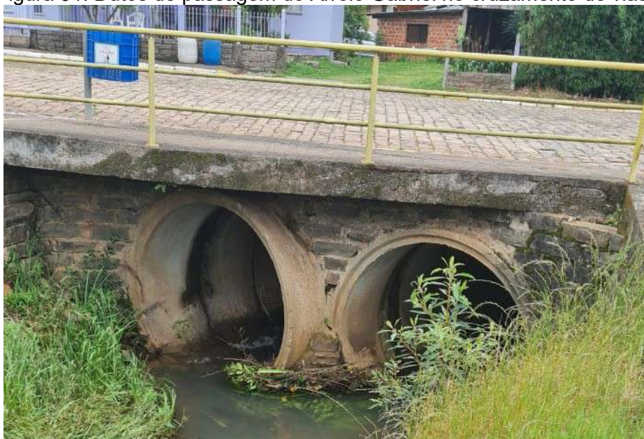
Figura 91: Dutos de passagem do Arroio Gabriel no cruzamento de vias.
