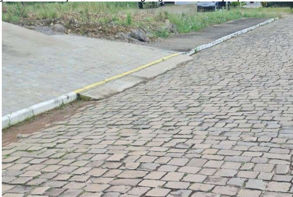
Figura 65: Intervenção em entrada de garagem sem tubulação para escoamento.
