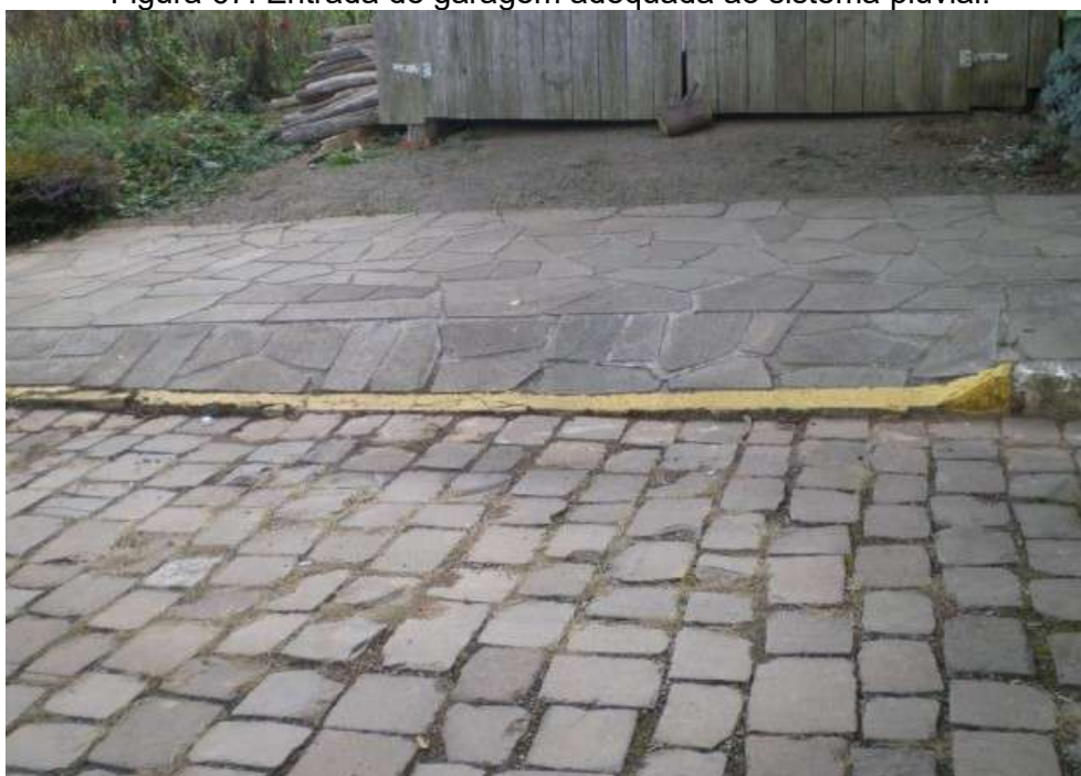
Figura 67: Entrada de garagem adequada ao sistema pluvial.
