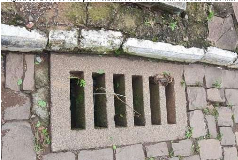
Figura 69: Boca de lobo pré-moldada de concreto com entrada horizontal.
