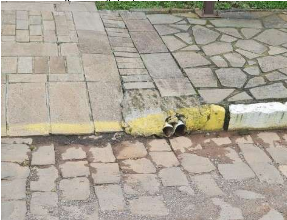
Figura 58: Ligação pluvial entre lote e sarjeta.
