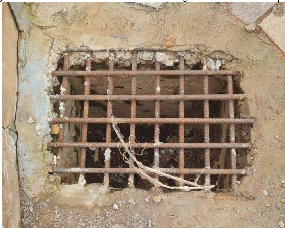
Figura 68: Boca de lobo de entrada horizontal com grade metálica conforme padrão.
