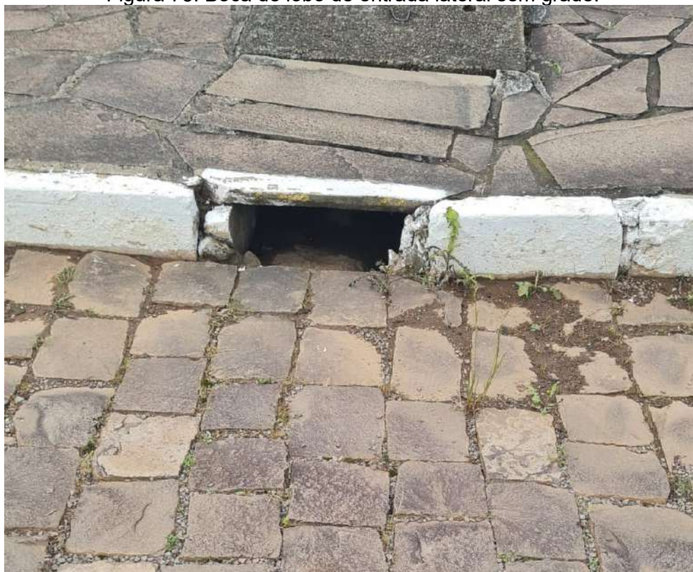
Figura 73: Boca de lobo de entrada lateral sem grade.
