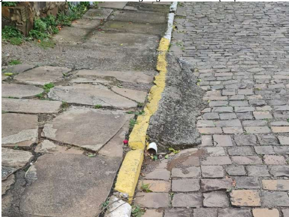
Figura 66: Intervenção em entrada de garagem com tubulação para escoamento.
