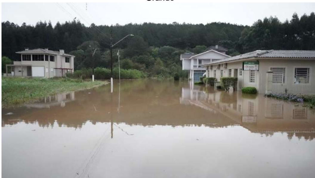
Figura 105: Registro fotográfico da enchente de 04 de setembro de 2023, Rua Carlos João Grando
