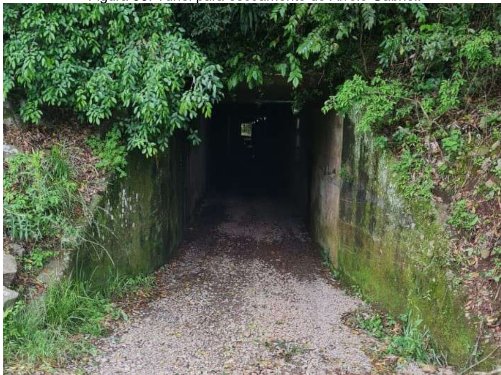
Figura 93: Túnel para escoamento do Arroio Gabriel.
