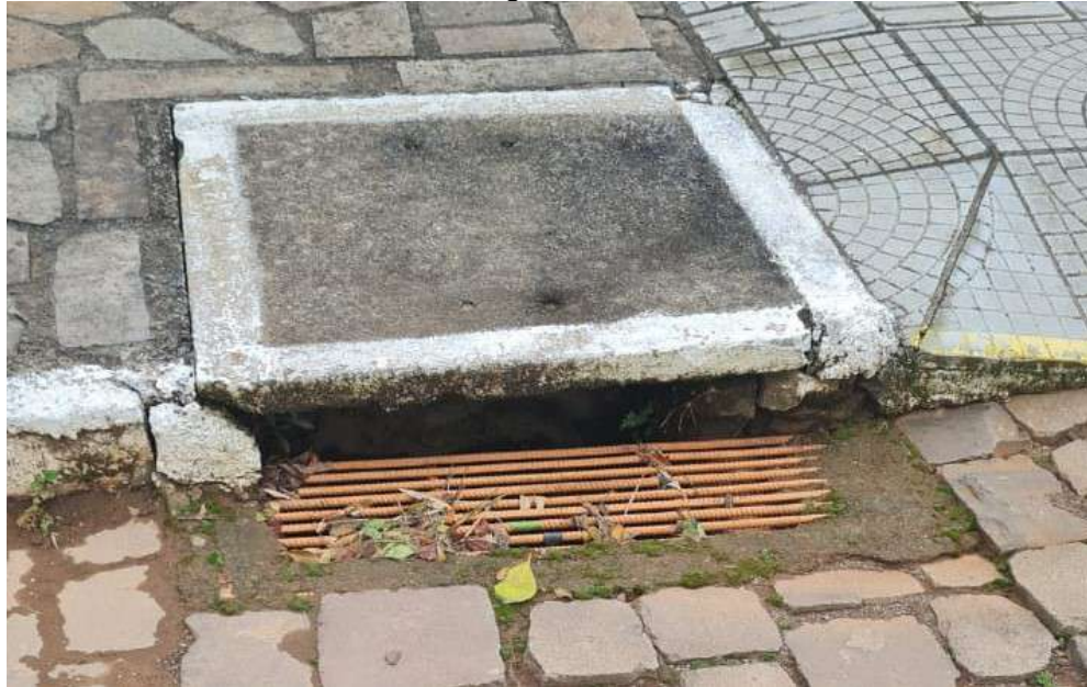
Figura 75: Boca de lobo de entrada horizontal com grade metálica e entrada lateral sem grade.
